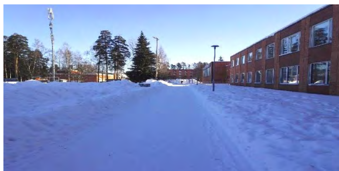
Kuva 72. Kourulan keskuksen liikennejärjestelmässä keskus-alue on autoilta kielletty ja kevyenliikenteen yhteydet kulkevat alueen sisäosissa. Kourulan monitoimisali ja koulurakennus, jotka molemmat sijoittuvat maaston tasoerokohtaan, rajaavat kevyenliikenteen väylää. Rakennukset ovat ylärinteen puolelta yksikerroksisia ja alarinteen puolelta kahden kerroksen korkuiset.
