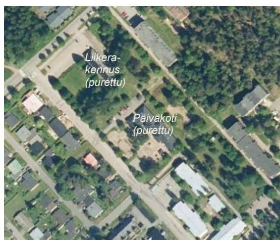
Kuva 77. Maanmittauslaitoksen ortoilmakuva Hovinpellosta vuodelta 2017. Hovinpellossa oli pieni aluekeskus, johon kuului päiväkoti ja liikerakennus. Liikerakennus ja päiväkoti on purettu ja korvattu uudella päiväkodillä. (Maanmittauslaitos)
