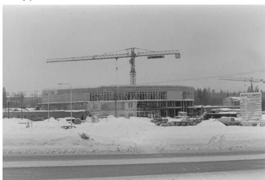
Kuva 89. Sammontori rakenteilla. Työmaakyltin mukaan rakentajana on toiminut YIT-Yhtymä. (Kuva: Lappeenrannan museot / Finna.fi)
