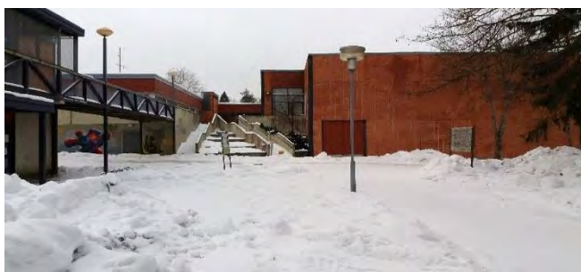
Kuva 212. Kourulan monitoimihalli valmistui vuonna 1980, eli kymmenen vuotta ennen Sammonlahden hallia. Rakennus sijoittuu rinnemaastoon. Kuvassa olevien portaiden yläsanteella oli alkuperäinen sisäänkäynti saliin. Saliosa oikealla.
