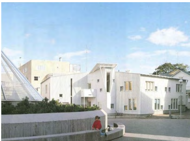
Kuva 114. Puurakenteinen päiväkoti Hertta on valmistunut vuonna 1987 ja sen on suunnitellut arkkitehdit Kari Järvinen ja Timo Airas. (Kuva: https://finnisharchitecture.fi/ / Kari Järvinen / MFA)
