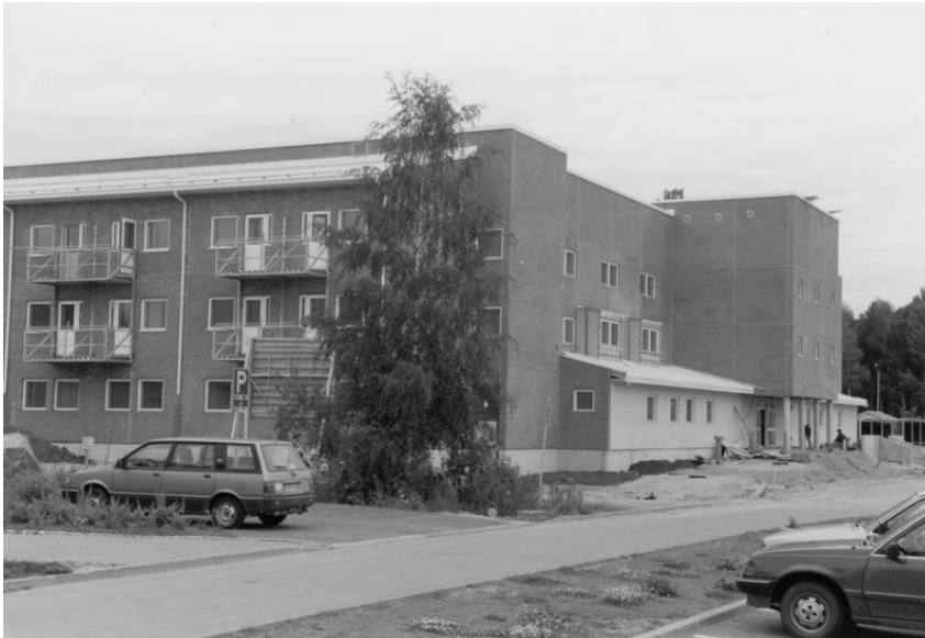
Kuva 231. Sammonkoti rakenteilla ja nähtynä Hietakallionkadun suunnasta. Kuva otettu 1990-luvun alussa. (Lappeenrannan museot / Finna.fi)
