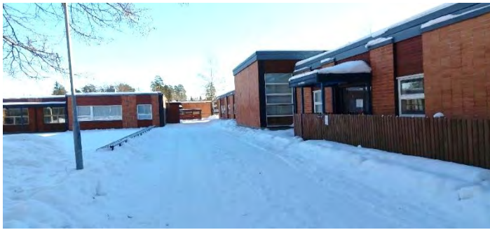
Kuva 177. Kuvassa oikealla ensimmäisessä vaiheessa valmistunut, nyttemmin jo purettu päiväkotikoulu. Vasemmalla alakoulu, joka sai rakennusluvan toisessa rakennusvaiheessa vuonna 1979 ja valmistui vuonna 1980.
