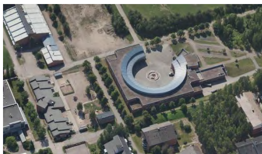
Kuva 154. Sammonlahden yläasteen koulu. Vasemmassa reunassa liikuntahalli ja päiväkotirakennus. (Blom viistoilmakuva 16.7.2018)
