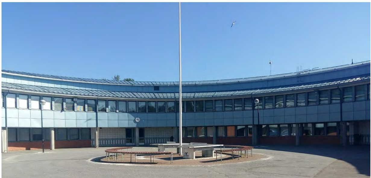
Kuva 166. Sisäpihan kaareva muoto, amfiteatterimainen massoittelu sekä sisäänvedetty ensimmäinen kerros luovat sisäpihalle varsin hienon arkkitehtonisen tilan, joka ei ole 1980-luvun tiukasti säädellyssä julkisessa rakentamisessa itsestäänselvyys.
