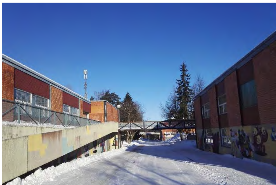
Kuva 73. Alueen läpi kulkee kevyenliikenteen raitteja. Rakennukset sijoittuvat rinnemaastoon ja osin ne on työnnetty rinteeseen. Osin näkyvissä on laajoja puhtaaksi valettuja betonisoskeleita, joita on sittemmin pyritty ehostamaan taideprojektein.
