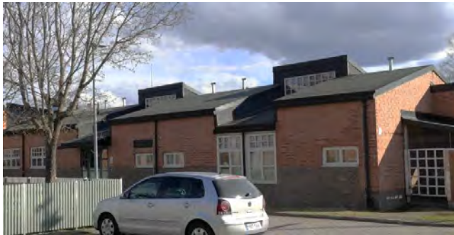
Kuva 117 Rakennuksen pohjoisjulkisivulla on nähtävissä julkisivua elävöittävä kivipinnoite sekä erilaisia ikkunatyyppejä. Kuvassa näkyy Ruskolahdenkatu, joka kulkee päiväkodin pohjoisreunassa. Saliosa työntyy katualueelle ikään kuin historiallisena jäänteenä, muodostaen tarinaa uudelle alueelle. Pohjoispuolen julkisivu on pääosin räystäätön.
