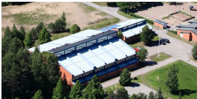
Kuva 195 Viistoilmakuva liikuntahallista koillisesta. Kattomuodot ovat vahva osa rakennuksen arkkitehtuuria. (Lappeenranta kaupunki)
