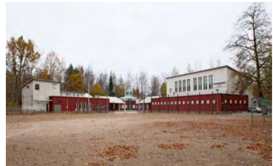
Kuva 144. Lähderannan koulu Espoossa. Julkisivuissa on käytetty punamullan väristä lautaverhousta ja ilmeikästä aukotusta. (Kuva AK/ark-byroo 2016 / Espoon kouluarkkitehtuurin vuosikymmenet).
