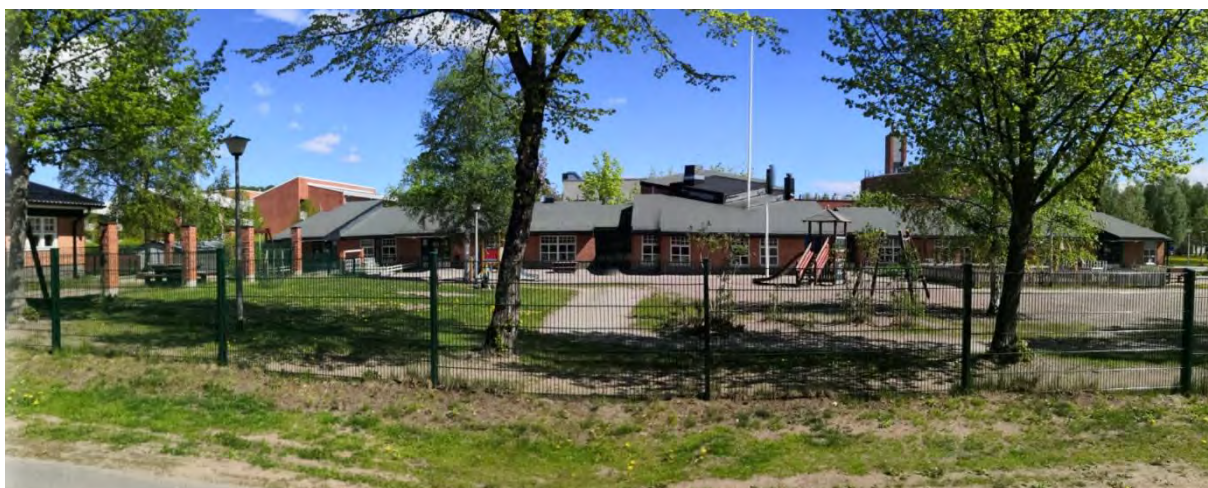
Kuva 119 Kuvassa näkyy kattomuotojen vaihtelua rakennuksen lounaispuolelta leikkipihan yli kuvattuna.
