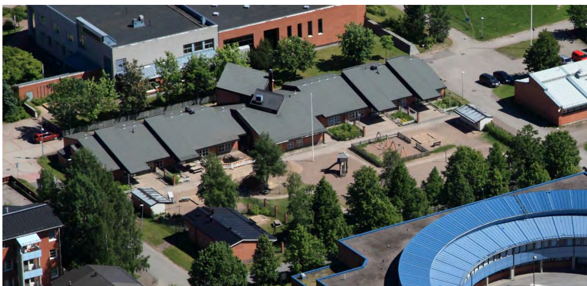
Kuva 116 Päiväkotirakennus viistoilmakuvassa. Pitkänmallinen päiväkoti sijoittuu kiinni Ruskolahdenkatuun, joka on päiväkodin kohdalla kevyelle liikenteelle varattu katu, jolla huoltoajo on sallittu. Tontin länsikulmalla on erillinen talonmiehen asunto. Oikeassa alakulmassa näkyy Sammonlahden yläkoulu. (Lappeenrannan kaupunki)
