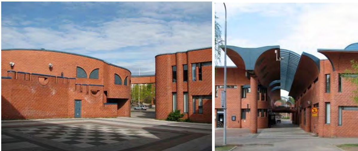
Kuva 29. Hervannan liikekeskuksen suunnittelivat punatiilestä plastisine muotoineen arkkitehdit Raili ja Reima Pietilä. Liikekeskus ja vapaa-aika- ja seurakuntakeskus valmistuivat vuonna 1979 ja toimintakeskus vuonna 1989. Kohde on nykyisin osa valtakunnallisesti arvokasta rakennettua kulttuuriympäristöä. (Kuva: http://www.rky.fi )
