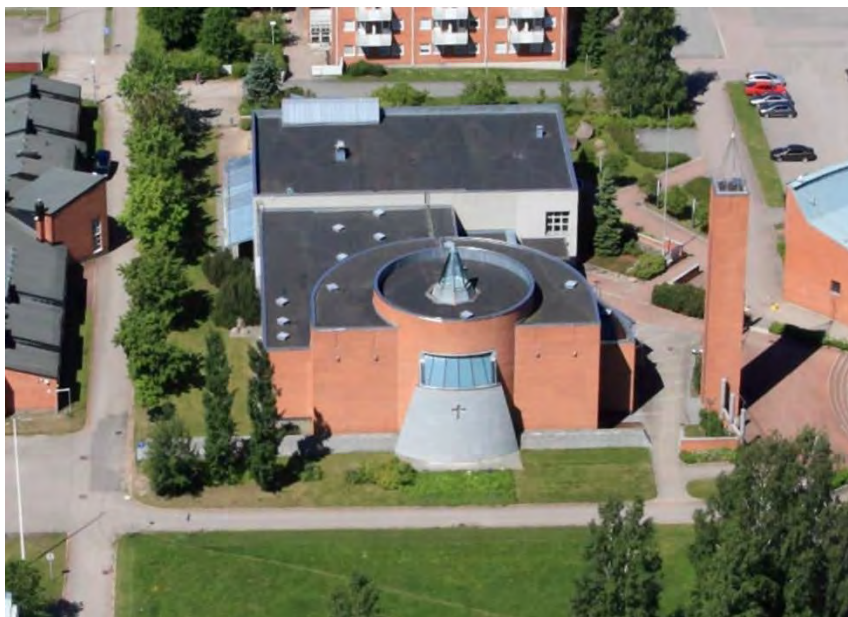
Kuva 38 Sammonlahden kirkko kuvattuna idän puolelta. Oikealla kirkontorni ja Sammontorin liike- ja palvelurakennus. Kirkon vasemmalla puolen on päiväkotia. (Lappeenrannan kaupunki)
