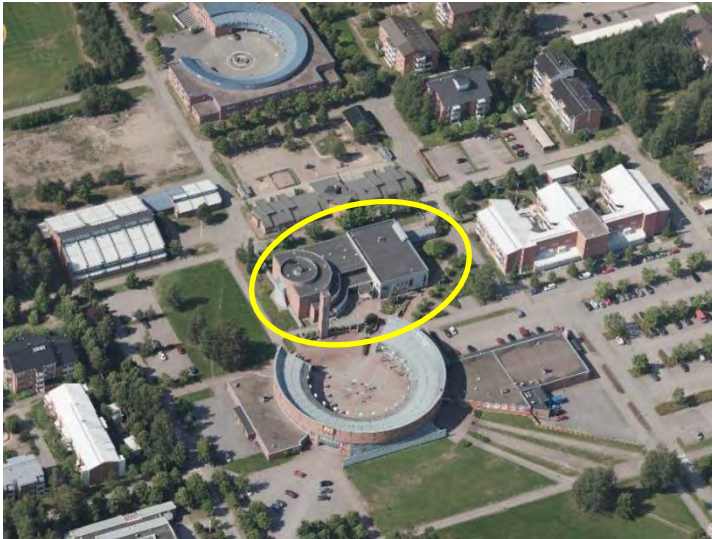
Kuva 236. Kirkko kuvassa keskellä. Sen koillispuolella on Sammontori, eteläpuolella Sammonlahden liikuntahalli, lounaispuolella päiväkotia ja koulu sekä luoteen puolella vanhustentalo. (Blom viis-toilmakuva)
