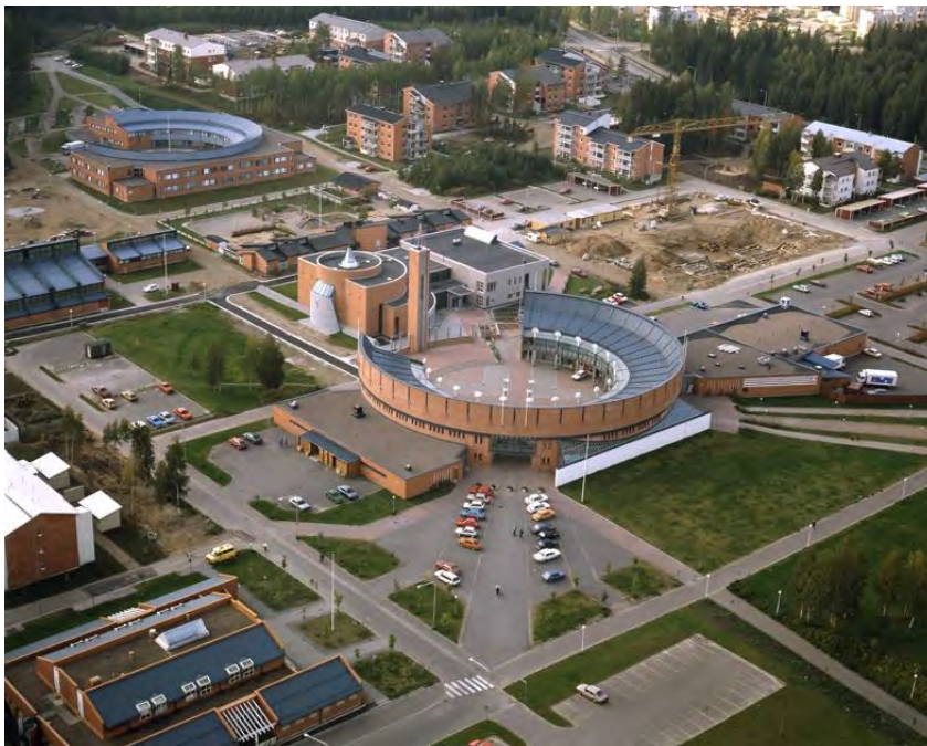
Kuva 33. Viistoilmakuva Sammonlahdesta. Vasemmassa alakulmassa terveysasema, keskellä Sammontori ja kirkko. Vasemmassa reunassa liikuntahalli ja koulu. Palvelutalo on rakenteilla. (Lappeenrannan museot / Scanfoto / Finna.fi)
