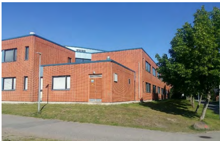
Kuva 156. Rakennuksen ulkokehä on muurimainen ja järjestelmällisesti aukotettu. Kulmaosat ovat hieman sisäänvedetyt ja yksikerrokset.
