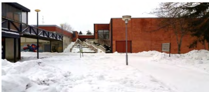
Kuva 75. Kuvassa oikealla monitoimisali ja keskellä sen alkuperäinen pääsisäänkäynti portaiden yläpäässä. Pääsisäänkäynti on poistettu myöhemmin. Vasemmalla silta kevyenliikenteenväylän yli monitoimiosan ja liiketilan välillä.
