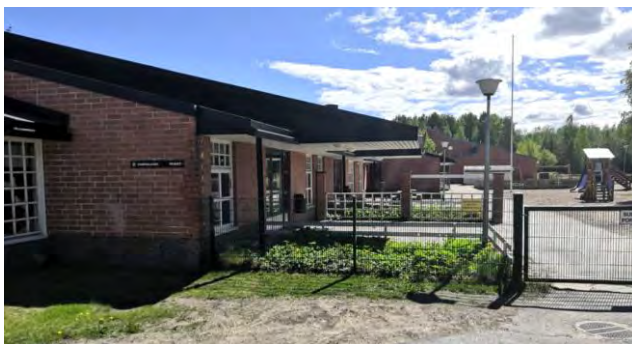
Kuva 118. Leikkipihan puolella jokaisen ryhmän sisäänkäyntiä suojaa matalammalle tuleva pitkä kattolape. Räystää suojavat myös liialta auringonpaahteelta.
